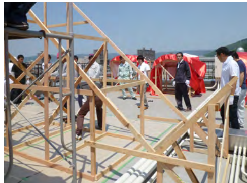
航空写真撮影3日前 運び込み・仮組
