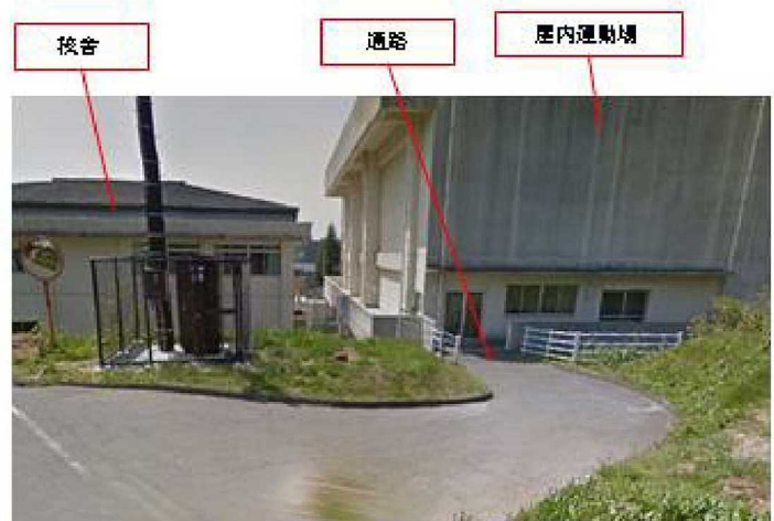
北から見た屋内運動場にある通路 (Googleストリートビュー2013年3月撮影より)
