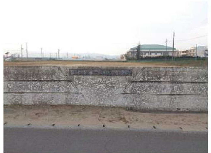
東から見た学校の敷地跡(2014/10/31撮影)
