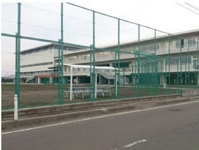
東から見た学校(2014/10/31撮影) ※震災後に建てられた新校舎。
