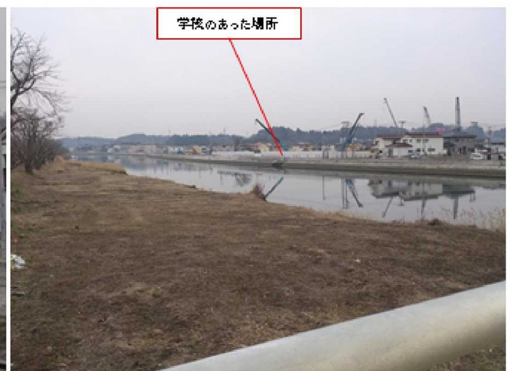
気仙沼大橋(北から見た学校と川(2014/3/18撮影))
