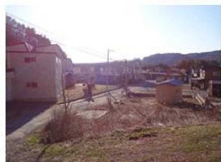
写真③ 体育館と校舎、東側から (2014/4/12撮影)
