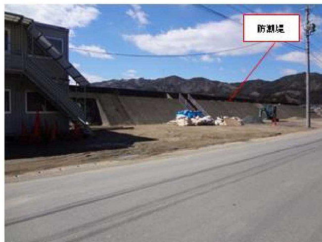
学校側から見た防潮堤(2014/3/19撮影)
