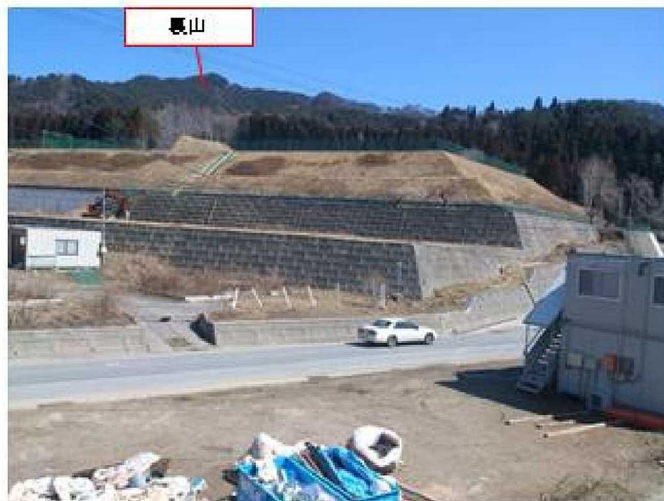
防潮堤の上から見た学校の敷地(2014/3/19撮影)
