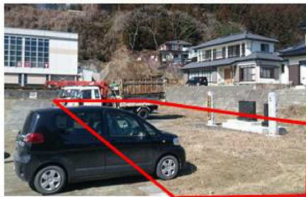
赤浜小学校の体育館と校舎跡(2014/3/19撮影)
