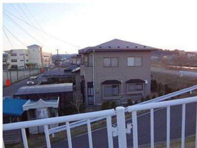
写真② 新長内橋南側から長内川上流向き (2014/4/12撮影)
