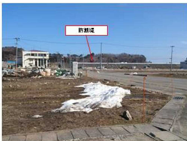
学校から約200m離れた防潮堤(2014/3/19撮影)
