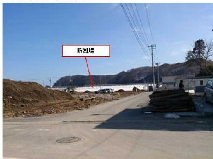
学校から約200m離れた防潮堤(2014/3/19撮影)
