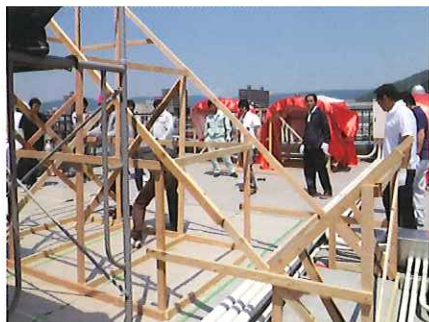
航空写真撮影3日前 運び込み・仮組
